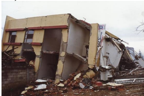
Şəkil 2. Binanın bir uzununa yanı üstə yıxılması
