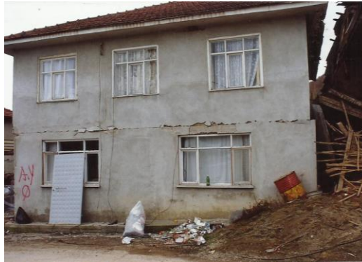
Şəkil 4. Zəlzələ zamanı mərtəbələrin sürüşməsi.
