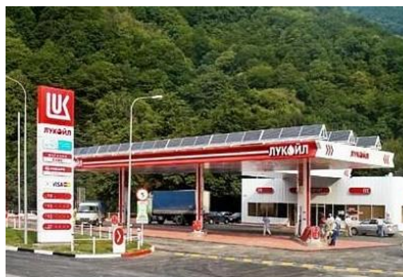
Рисунок 7 а) Солнечные батареи на парковках; б) Автозаправочная станция Лукойл на солнечных батареях мощностью 9,6 кВт
