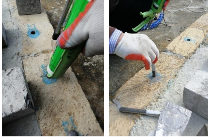
Şəkil 6. Baza nümunəsində mişardaşı kütləsində anker millərinin quraşdırılması
