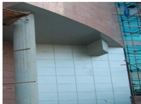
Рис. 2. а) фасадная система с облицовочными элементами из композитного материала с отсутствующими зазорами между облицовочными элементами и с отсутствующим входом в воздушный зазор; б) Фасадная система с отсутствующими зазорами между облицовочными элементами из композитного материала и с горизонтальным участком воздушного зазора
