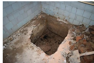
Şəkil 7. Binanın daxilində qazılmış şurf
