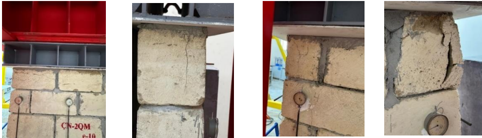
Şəkil 9. Mərkəzdən xaric sıxılma zamanı çevik rabitəli boşluqlu divar nümunələrində zədə və çatlar.
