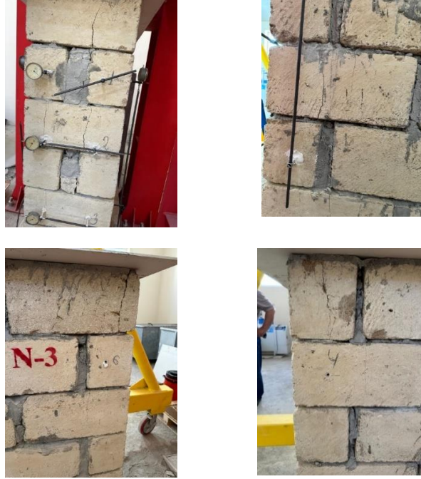
Şəkil 8. Mərkəzdən xaric sıxılma zamanı sərt rabitəli nümunələrdə zədə və çatlar.
