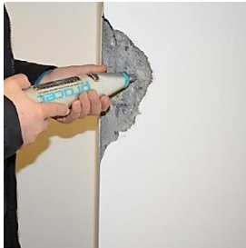
Şəkil 3. Betonun möhkəmliyinin “Şmidt-Hammer” sklerometri vasitəsilə təyini
