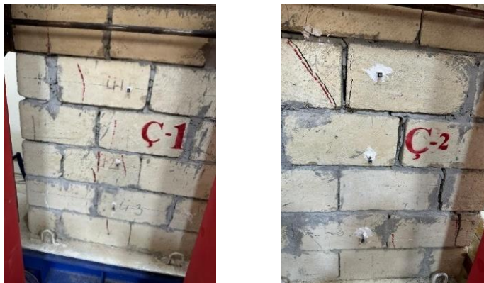
Şəkil 10. Sərt (a) və çəvik (b) rabitəli boşluqlu divar nümunələrində üfüqi yükün təsirindən yaranan zədə və çatlar
