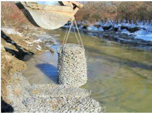
Рис. 8. Укладка в берегоукрепительную конструкцию габиона круглогомата «Officine Massaferrì»
