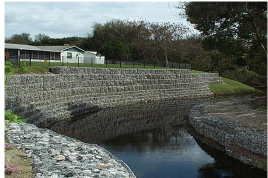
Рис. 7. Укрепление берега реки коробчатыми и матрасными габионами «Officine Massaferrì»
