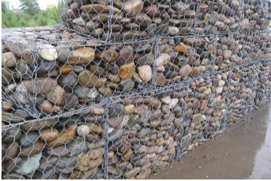
Рис. 6. Укрепление берега коробчатыми габионами «Officine Massaferrì»
