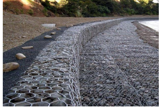
Рис. 7. Укрепление берега реки коробчатыми и матрасными габионами «Officine Massaferrì»
