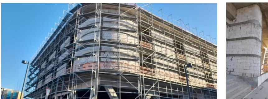
Şəkil 2. Məsaməli bloklardan tikilən divarlar, Bakı, Ağ şəhər.
