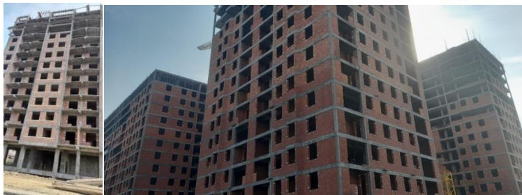
Şəkil 1. Kərpicdən tikilən binalar, Bakı ş.
