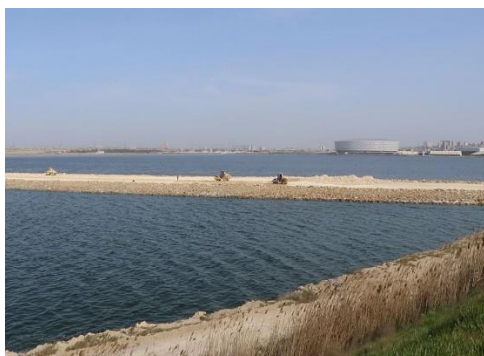
Рис.2. Фото процесса строительства дамбы на озере Буюк-Шор
