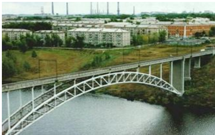
Рис.2. Общий вид моста через р. Исеть вблизи г. Каменск-Уральский
