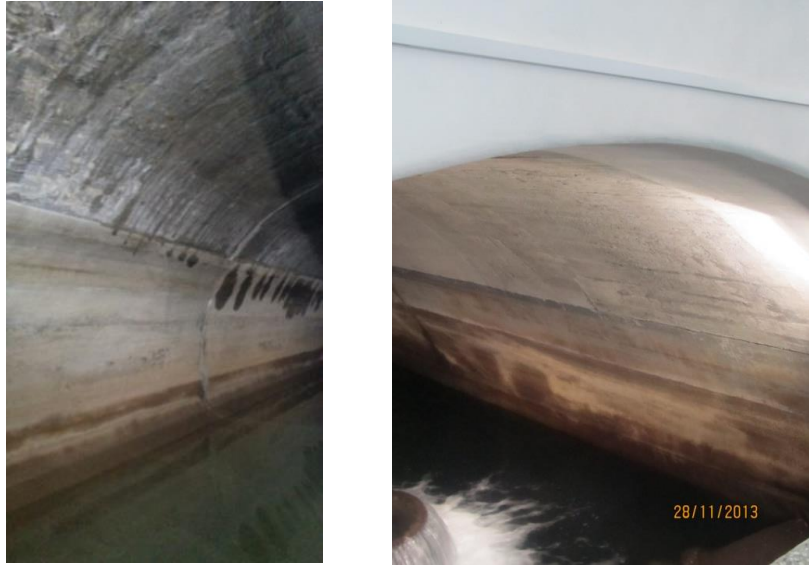
Şəkil 1. Şollar su anbarının daxili görünüşü
