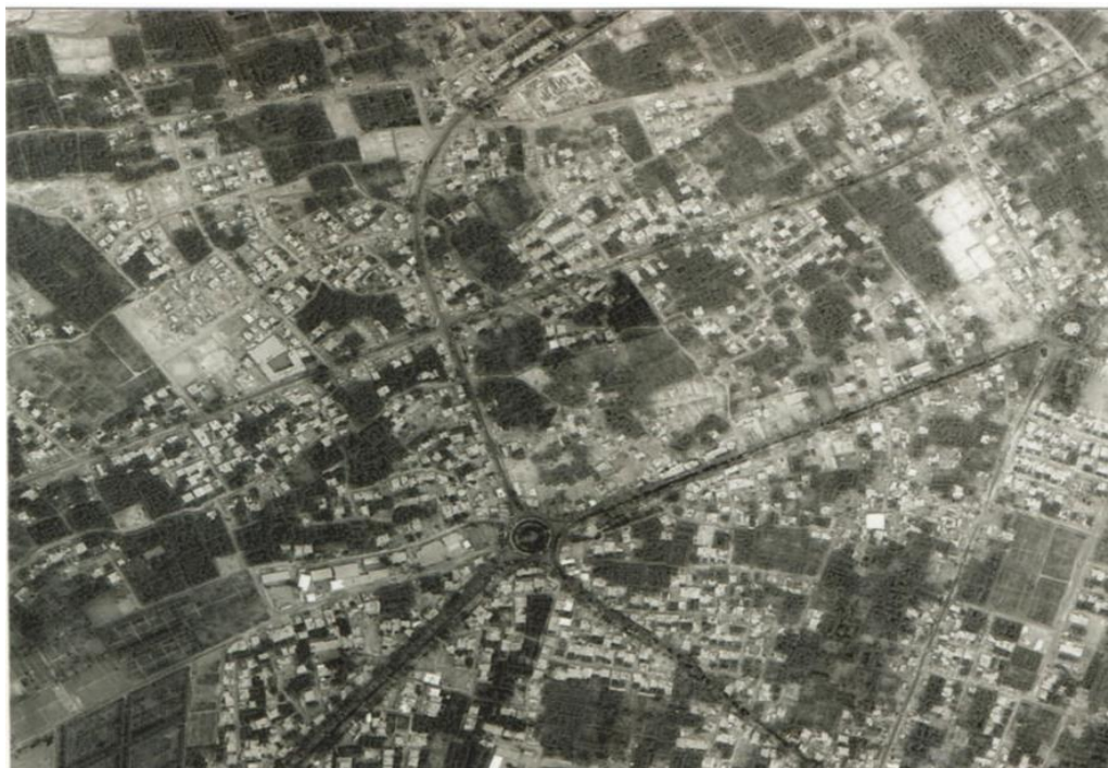
Рис. 2. Аэрофотоснимок части города Бам после катастрофического землетрясения 2003 года.
