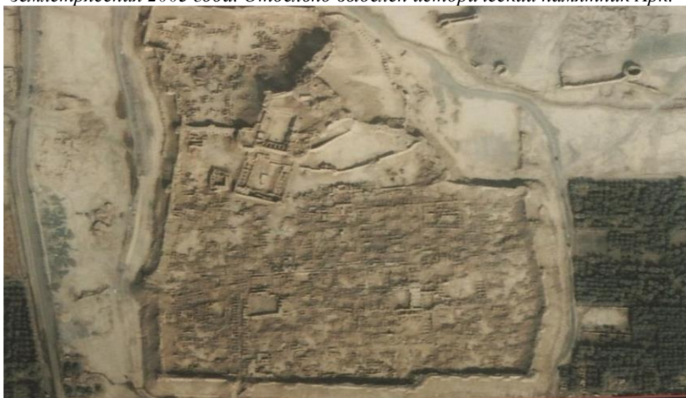
Рис.6. Аэрофотоснимок разрушенного исторического памятника Арк. после катастрофического Бамского землетрясения 2003 года.
